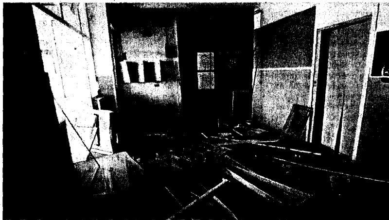
El antiguo edificio está abandonado desde hace más de un año y su deterioro va en aumento | SANDRÁ ALONSO
